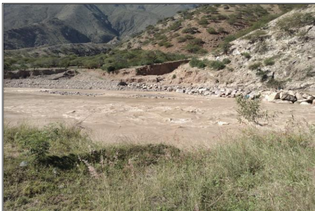
Fotografía Nº 02: Canal Perlamayo en el Tramo 7+000 – 7+140 con los derrumbes de la ladera saturada por las intensas lluvias y las filtraciones
